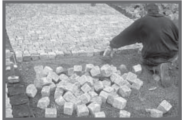
Bild 2: Für Reihenpflaster sind nach DIN EN 1342 Steine mit gesägten Seitenflächen erforderlich, wenn bei der Bestellung keine verringerten Maßabweichungen vereinbart wurden.
